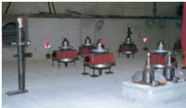
Jeder BW-Fixator® wird vom Achsen-System einzeln eingemessen, somit keine Folge-Fehler. Das Niveau wird mit einem Nivelliergerät eingemessen.
