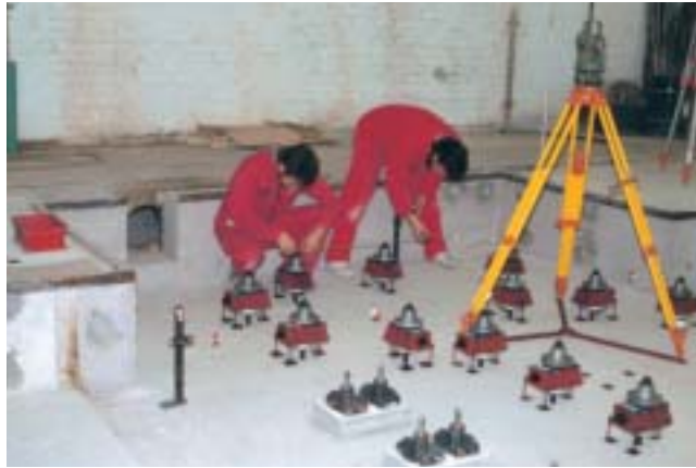
Einmessen der Lage der BW-Fixatoren® ausgehend von einem mittels Spanndrähten erstellten Koordinatensystems.
