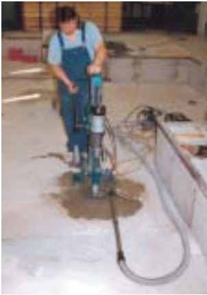
Ausbohren der Ankerlöcher mit Kernlochbohrmaschinen
